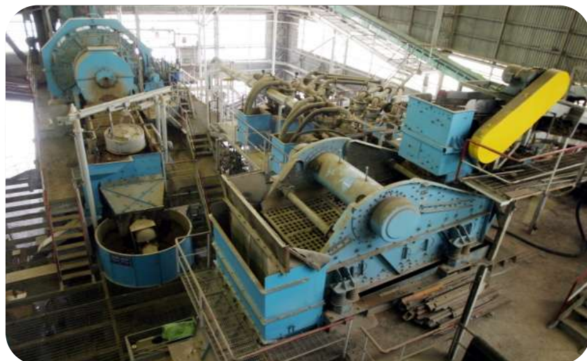
浄化等処理施設（浄化）
