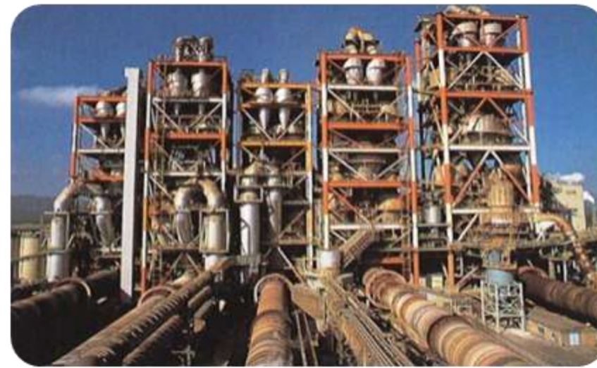
セメント製造施設
