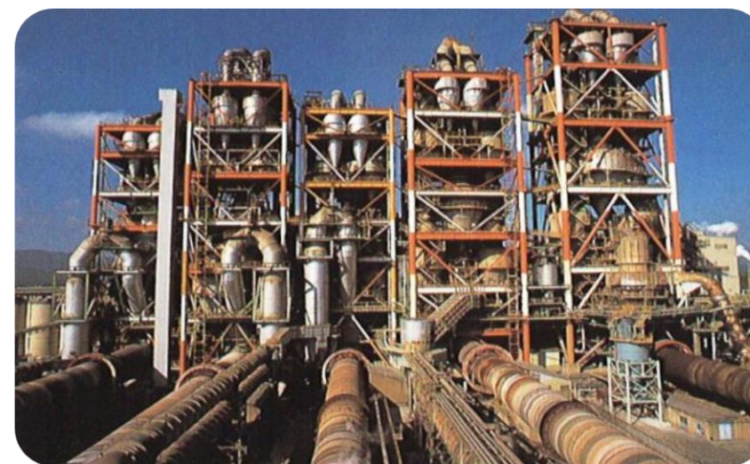
セメント製造施設
