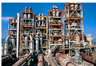
セメント製造施設
