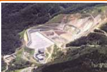
埋立処理施設
