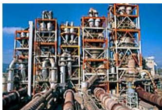
セメント製造施設
