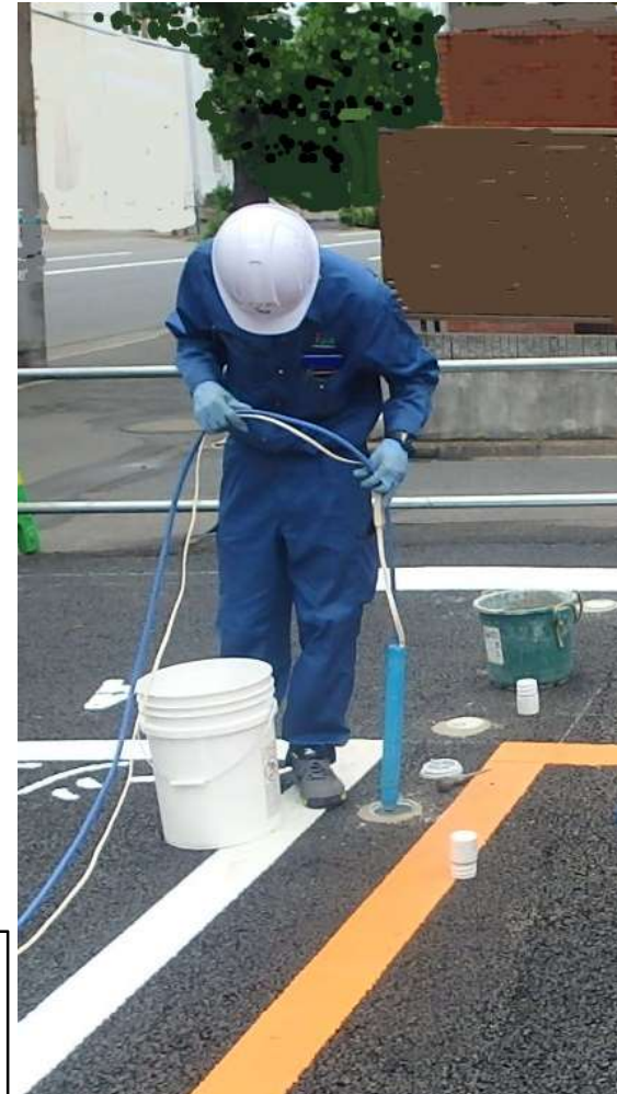
パージポンプによる 揚水状況
