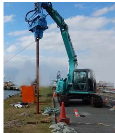
バックホー+ バイブロハンマ
