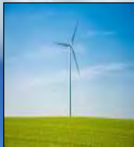
風力発電設備
